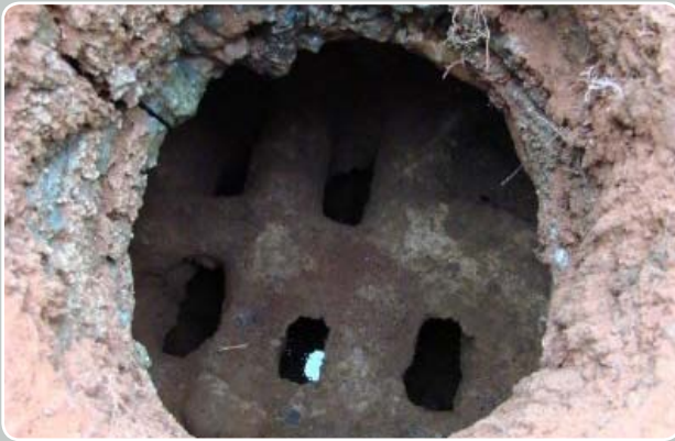
Blick von oben auf den „Rost“
